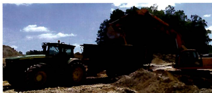
Lavori di costruzione
